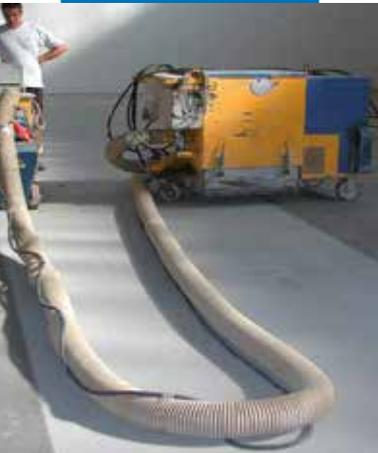
Preparazione del supporto mediante pallinatura
