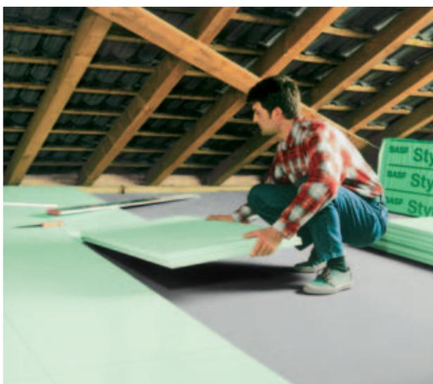
Fig. 10: Isolamento di un sottotetto con Styrodur® C.
