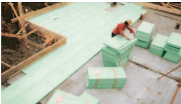
Fig. 4: Posa di lastre di Styrodur C.
