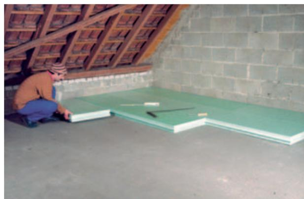
Fig. 2: Isolamento del sottotetto con Styrodur C.
