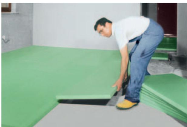
Fig. 19: Isolamento del pavimento della cantina.
