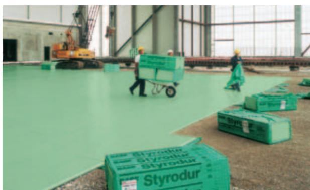
**Fig. 23:** Isolamento del pavimento di un capannone con Styrodur® C.
