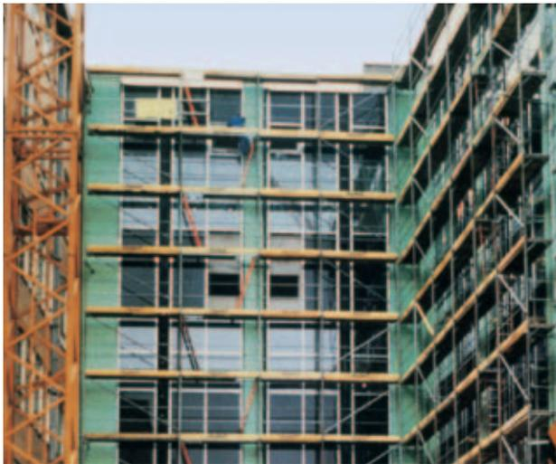
Fig. 7: Isolamento di ponti termici con Styrodur® 2800 C.
