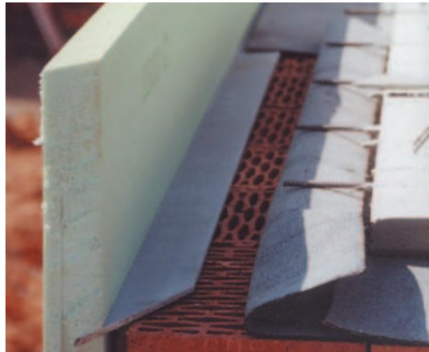
Fig. 8: Cassaforma perimetrale per solai con Styrodur 2800 C.
