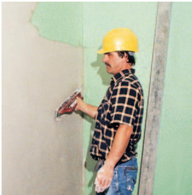
**Fig. 32:** Stesura del primo strato di intonaco adesivo a base di gesso; spessore dell'applicazione 10 mm.
