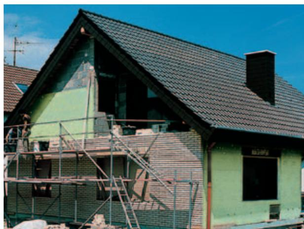
**Fig. 39:** Isolamento in intercapedine con Styrodur C.
