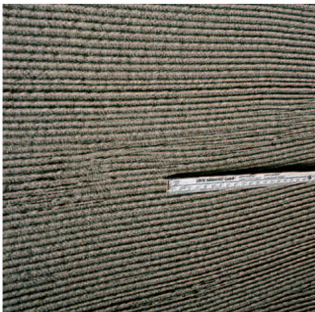
**Fig. 24:** Stesura orizzontale dello strato adesivo sull'isolamento con Styrodur® 2800 C.
