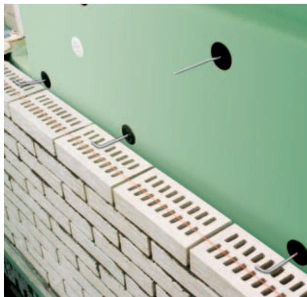
Fig. 40: Controparete in pietra arenaria calcarea, fissaggio con tasselli perforanti.
