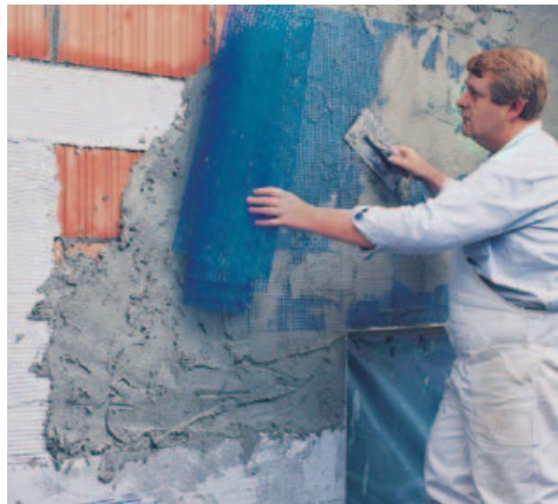
Fig. 22: Applicazione dell'intonaco di fondo e posa dell'armatura con rete in fibra di vetro sugli elementi strutturali in calcestruzzo isolati.
