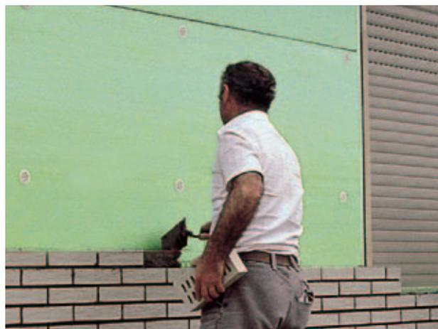
**Fig. 38:** Isolamento in intercapedine con mattoni della parete anteriore di larghezza 9 cm.
