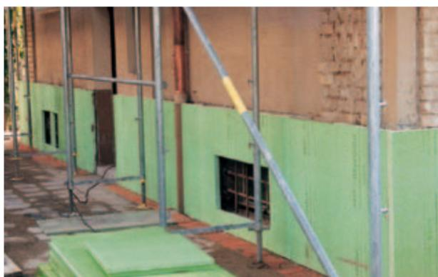
**Fig. 17:** Successivo isolamento dello zoccolo con Styrodur 2800 C.
