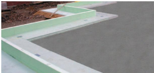
Per evitare in alcune zone una fondazione più costosa fino alla profondità del gelo è necessaria una schermatura antigelo ai sensi dell'EN ISO 13793. La schermatura si applica all'elemento marginale e viene inserita come isolamento orizzontale del terreno.
