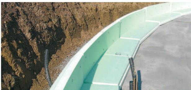
Gli elementi marginali arrotondati e prefabbricati vengono disposti e posati in base ai raggi necessari. In questo modo è possibile produrre esattamente e precisamente anche perimetri circolari della piastra di fondazione.
