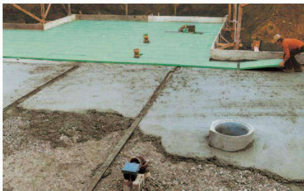
**Fig. 6:** Strato di protezione in calcestruzzo magro per la posa dell'isolamento del pavimento.
