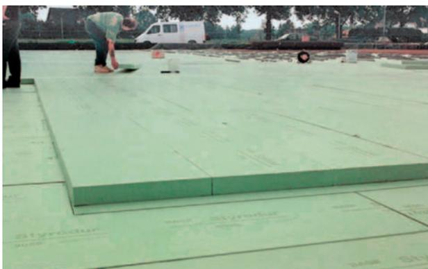
Fig. 8: Posa a vari strati di lastre di Styrodur® C sotto la soletta ai sensi dell'Omologazione Z-23.34-1325.
