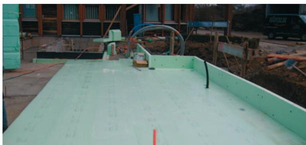
Le lastre di Styrodur® C con battentatura perimetrale continua vengono posate con allineatura sfalsata nel primo strato isolante. L'inizio e la direzione della posa devono essere effettuati in relazione all'oggetto e individualmente in base a progetti di montaggio pronti.
