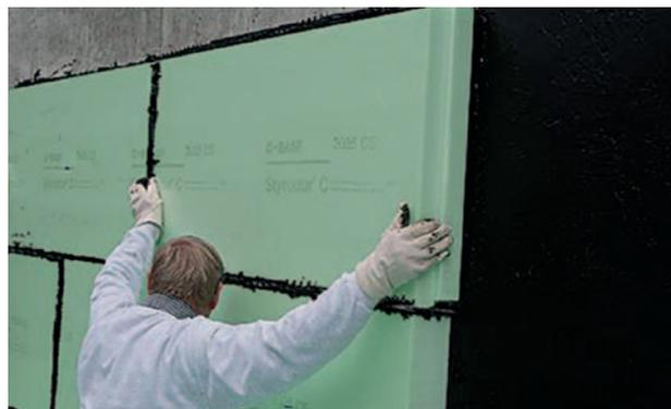
Fig. 17: Applicazione delle lastre di Styrodur® C e stuccatura dei giunti contro l'acqua in pressione.
