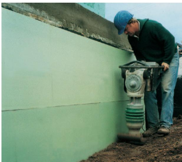
Fig. 28: Riempimento a strati dello scavo di fondazione e compattazione meccanica.
