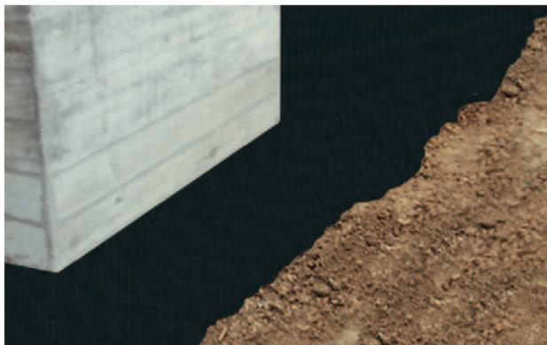
Fig. 15: Impermeabilizzazione della parete della cantina contro l'acqua in pressione.
