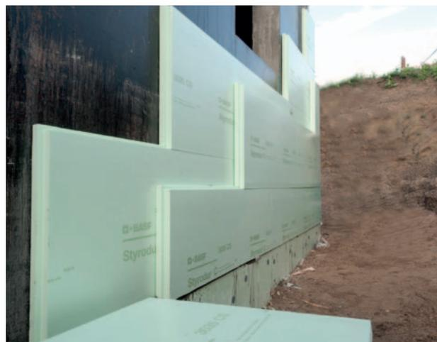
**Fig. 3:** Realizzazione di un isolamento perimetrale a due strati di Styrodur® C fino a riempimento dello scavo di fondazione.
