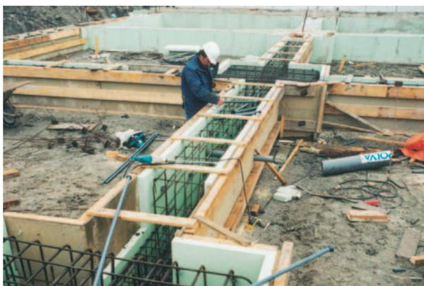
Fig. 25: Cassaforma con Styrodur® C.
