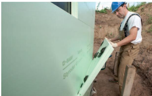
**Fig. 5:** Incollaggio a punti del secondo strato Lastre di Styrodur C con battentatura e giunti sfalsati.
