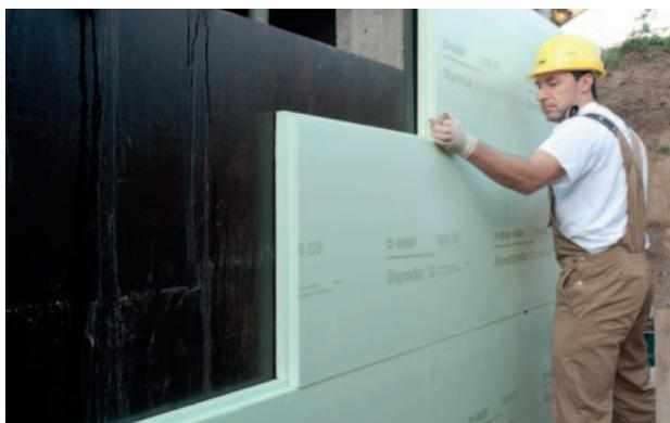
**Fig. 4:** La posa allineata delle lastre di Styrodur® C garantisce un isolamento perimetrale senza ponti termici.
