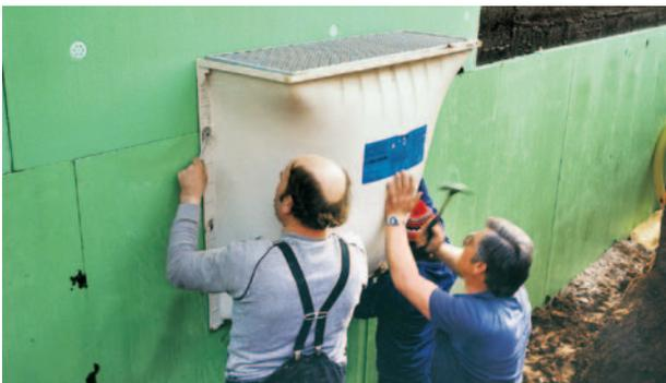
Fig. 22: Montaggio del lucernario nell'isolamento perimetrale.
