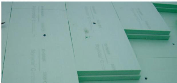
Con ferri piegati ad uncino per materiale isolante si fissa l'adesione l'uno all'altro dei singoli strati isolanti. Risulta quindi un fondo senza giunti e stabile.
