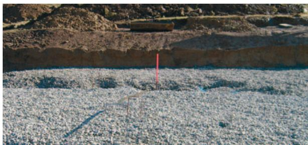
Un letto di pietrisco come strato di protezione e piano di livellamento garantisce un fondo di costruzione piano. Questo strato portante viene riempito conformemente ai requisiti imposti al terreno di costruzione e ai dati dell'esperto di statica.
