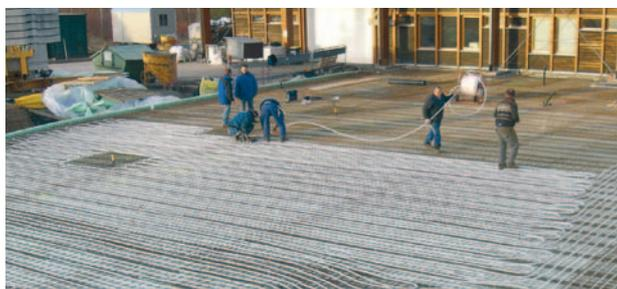
La piastra di fondazione attivata termicamente serve da accumulatore termico a grande superficie e comporta un risparmio in termini di energia di fino al 30 per cento. La riduzione della struttura del pavimento garantisce un miglioramento supplementare dell'altezza dei locali.
