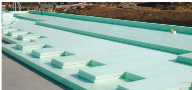
Il terzo strato isolante deve essere installato analogamente al primo strato. Con una colla speciale si devono incollare gli elementi superficiali del terzo strato nella parte frontale dell'inclinazione marginale. In questo modo si migliora la stabilità complessiva del sistema.
