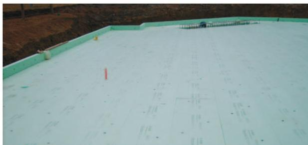
Per una piastra di fondazione esatta e senza ponti termici sono determinanti due fattori essenziali: lo strato isolante a tre strati di Styrodur® C omologato dall'ente di vigilanza e una prosa lavorativa professionale con piani di montaggio e di posa comprensibili.
