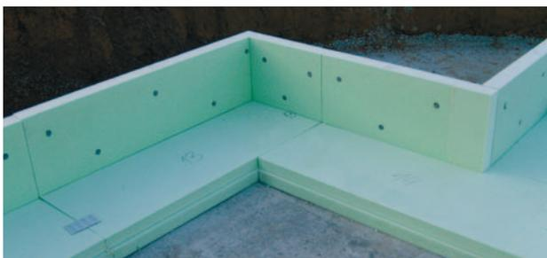
Elementi angolari prefabbricati e numerati esattamente garantiscono una posa degli elementi marginali esatta al millimetro anche in caso di perimetri di edifici articolati, evitando così le operazioni di misurazione e cassaformatura della piastra di formazione, che richiedono molto tempo.
