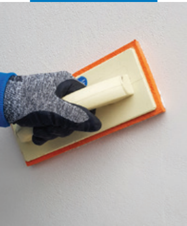
Rifinitura con frattazzino di spugna di PoroMap Finitura Civile
