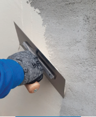
Applicazione di PoroMap Finitura Civile su intonaco stagionato
