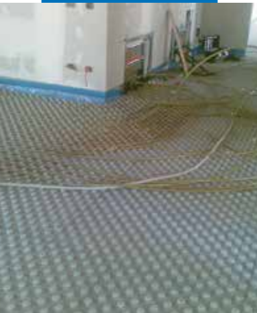
Preparazione dell'impianto radiante a pavimento
