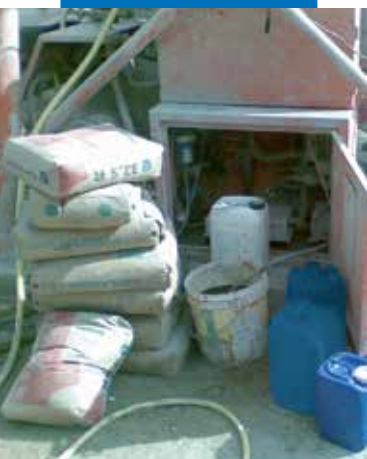
Sistema meccanizzato per il dosaggio di Mapescreed 704
