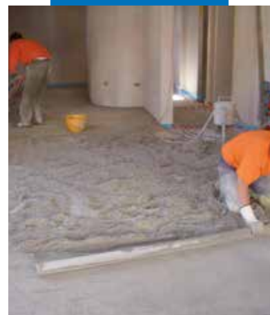
Stesura dell'impasto ottenuto con Mapescreed 704
