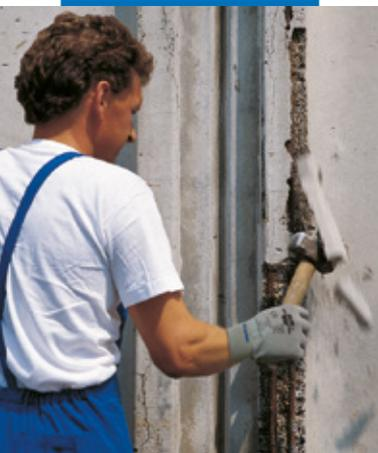
Demolizione del calcestruzzo degradato
