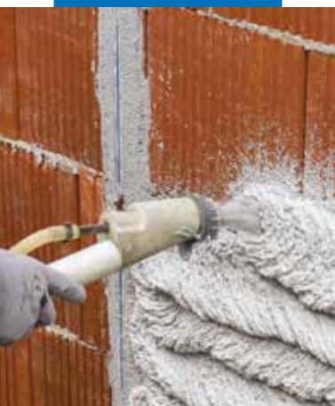
Applicazione di Intomap R2 Fibro con intonacatrice
