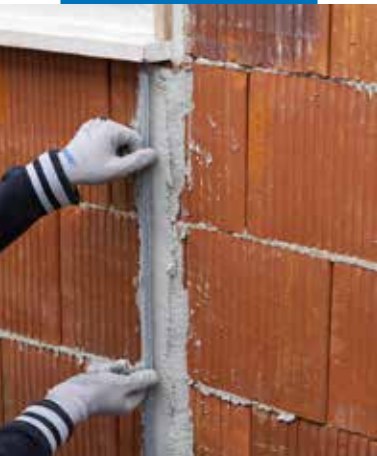
Posizionamento delle guide verticali
