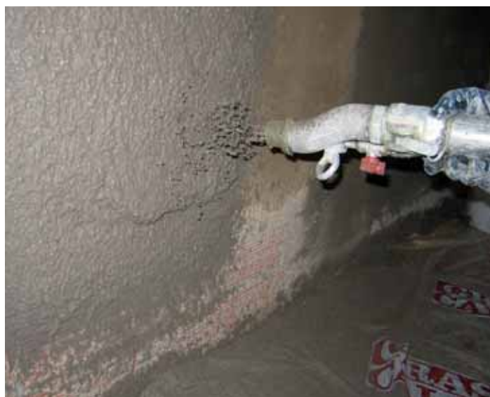
MALTA BASTARDA FIBRORINFORZATA può essere applicata a mano oppure pompata con idonea pompa (tipo Step 120 di Imer International).
