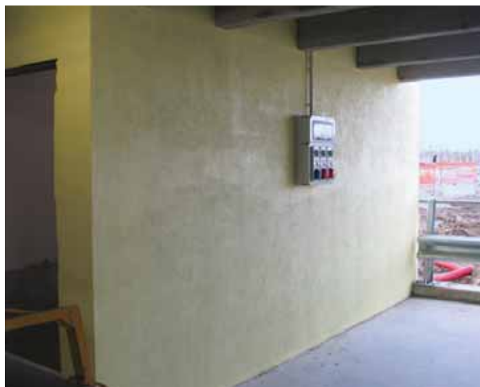
Interno di un padiglione della fiera Pero-Rho, intonato con MALTA BASTARDA FIBRORINFORZATA.
