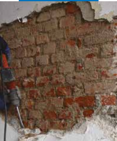
Demolizione dell'intonaco esistente
