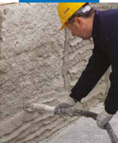
Applicazione di PoroMap Deumidificante con intonacatrice
