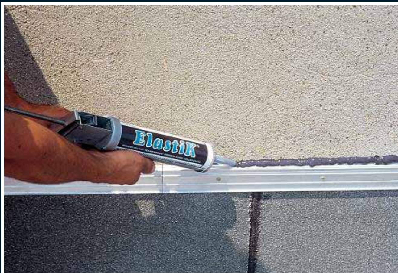
La sigillatura impermeabile dei particolari anche umidi
