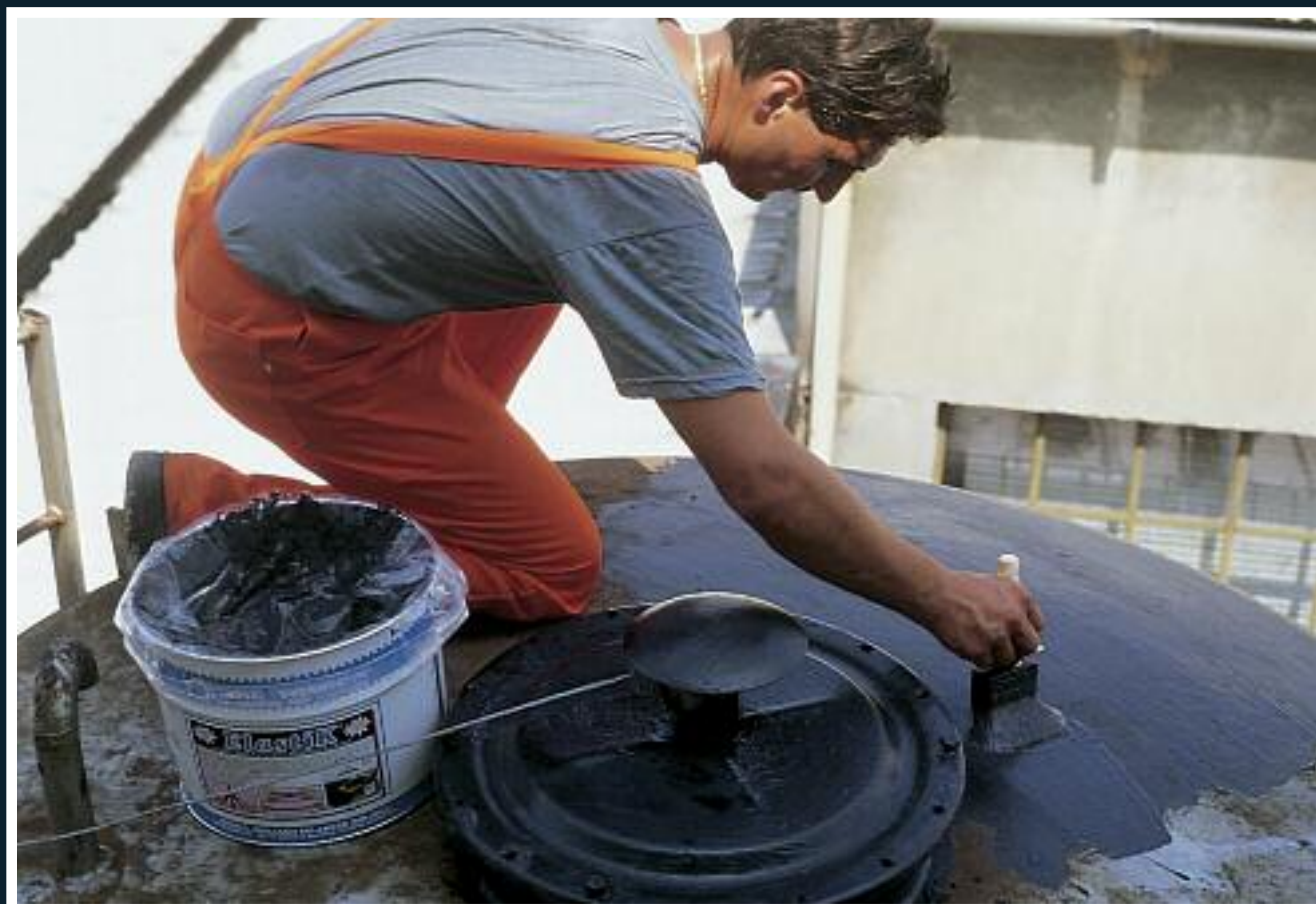
La protezione antiruggine ed impermeabile di tutte le superfici metalliche
