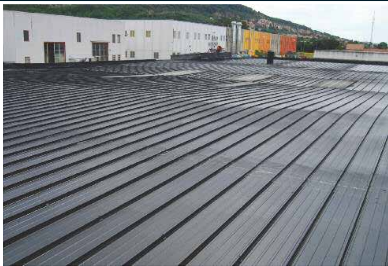
Aspetto della copertura metallica dopo il trattamento realizzato con due mani di ElastiK stese a distanza di 48 ore una dall'altra (applicazione a spruzzo con un consumo totale di 1 kg/m 2 )
