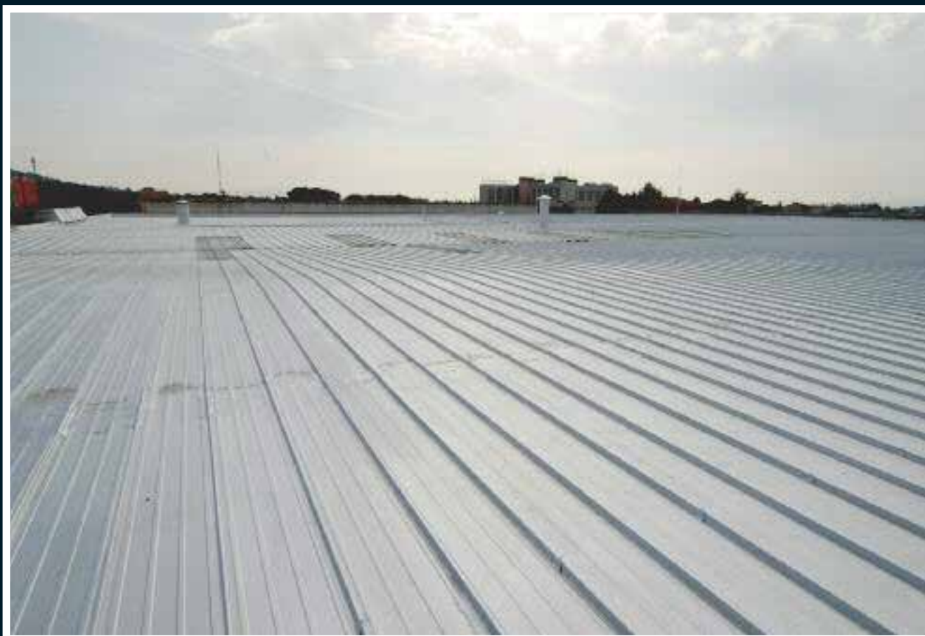
Aspetto della copertura metallica finita dopo il trattamento realizzato con una mano di vernice all'alluminio tipo Allumisol 12/14 steso dopo 20 giorni dalla seconda mano di ElastiK (applicazione a spruzzo con un consumo totale di 200 g/m 2 )
