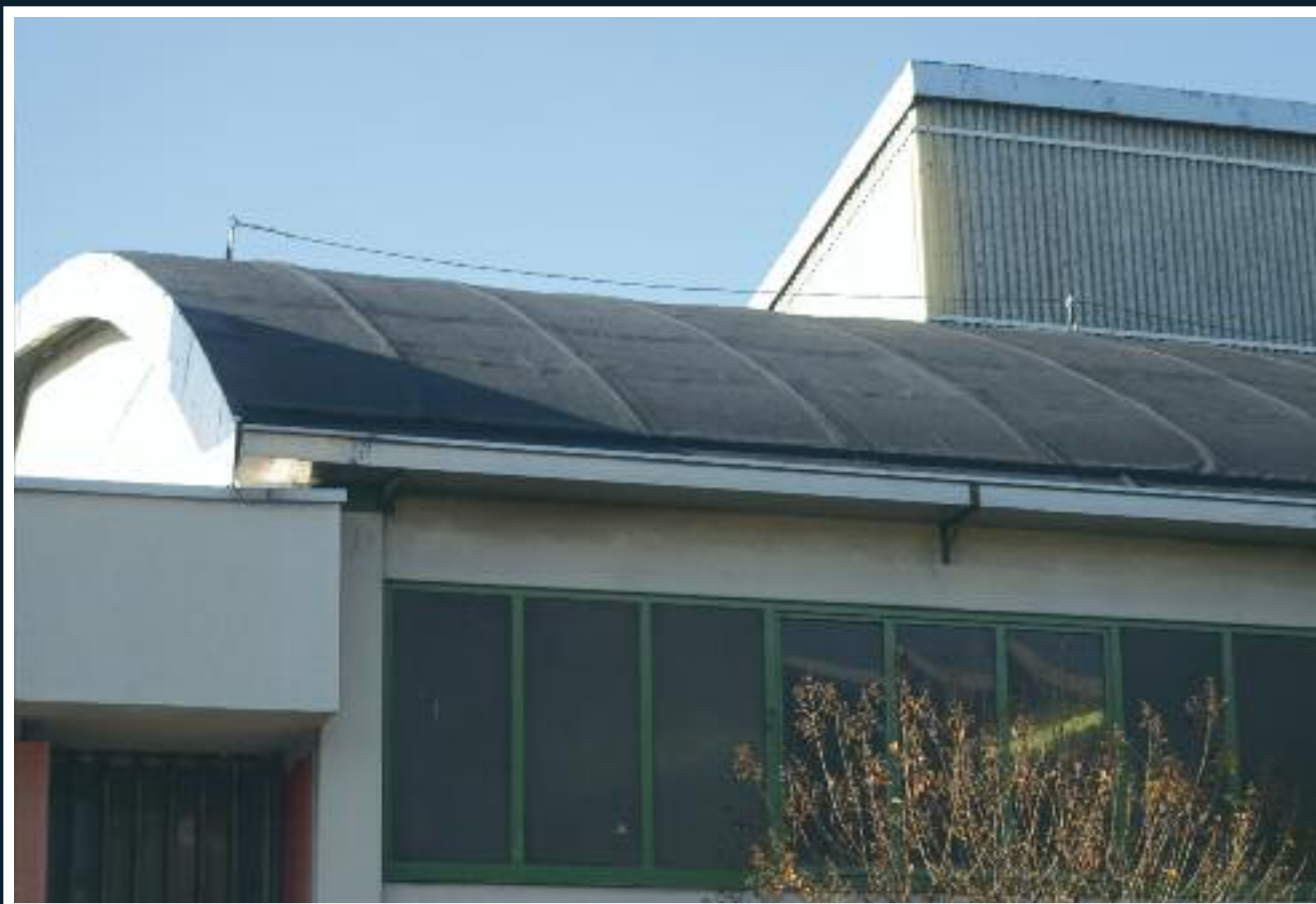
Nelle manutenzioni per il rinnovamento delle guaine bituminose invecchiate
