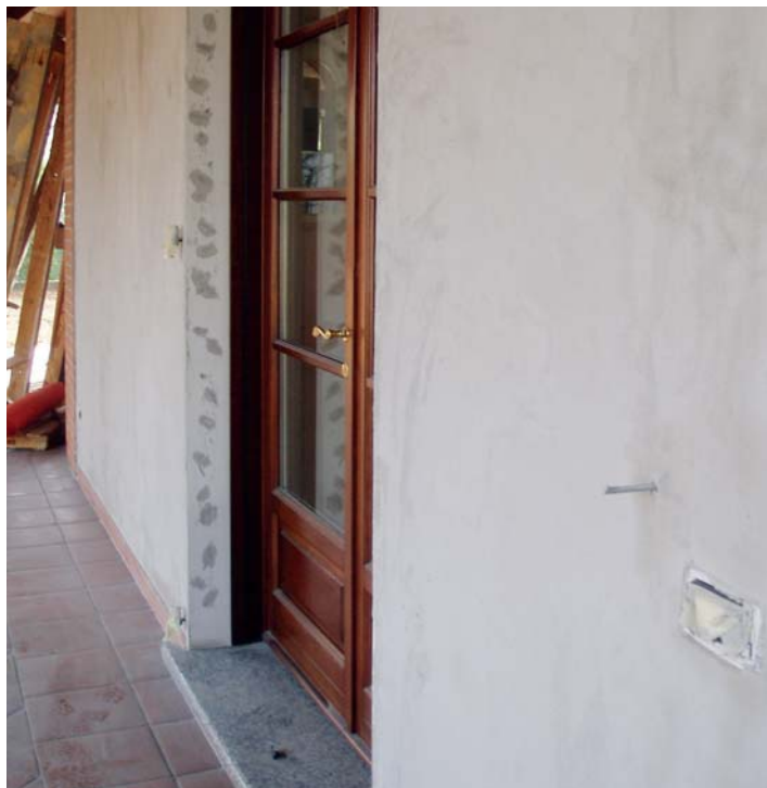
Prima fase di rasatura di muro esterno con FIBROFIN miscelato con RASATUTTO SUPERIOR.
